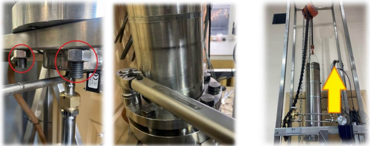
Рисунок В5 – Демонтаж корпусу витіснювача
