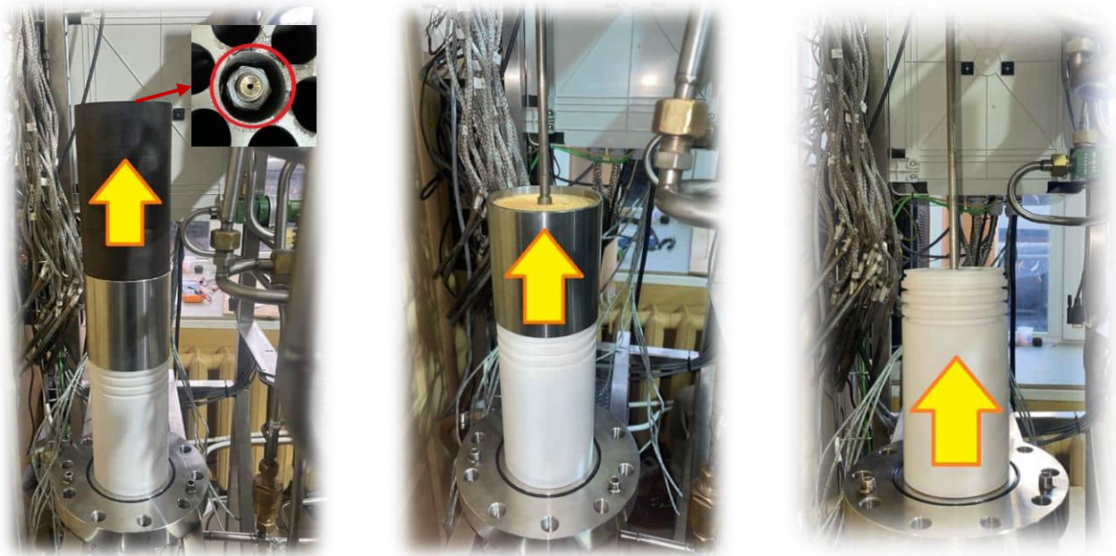
Рисунок В6 – Демонтаж верхньої секції, регенератора та нижньої секції витіснювача
