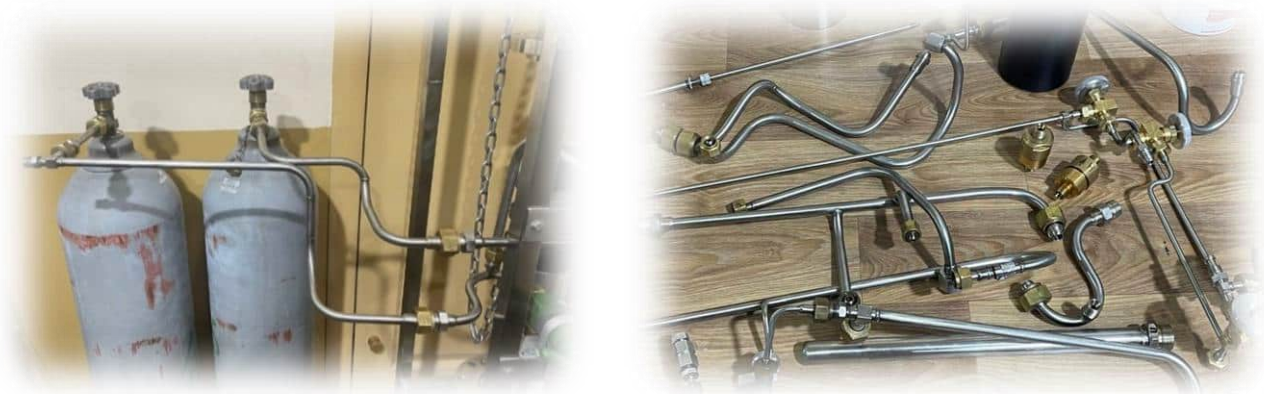
Рисунок В2 – Балони з робочим газом Рисунок В3 – Демонтовані трубопроводи
