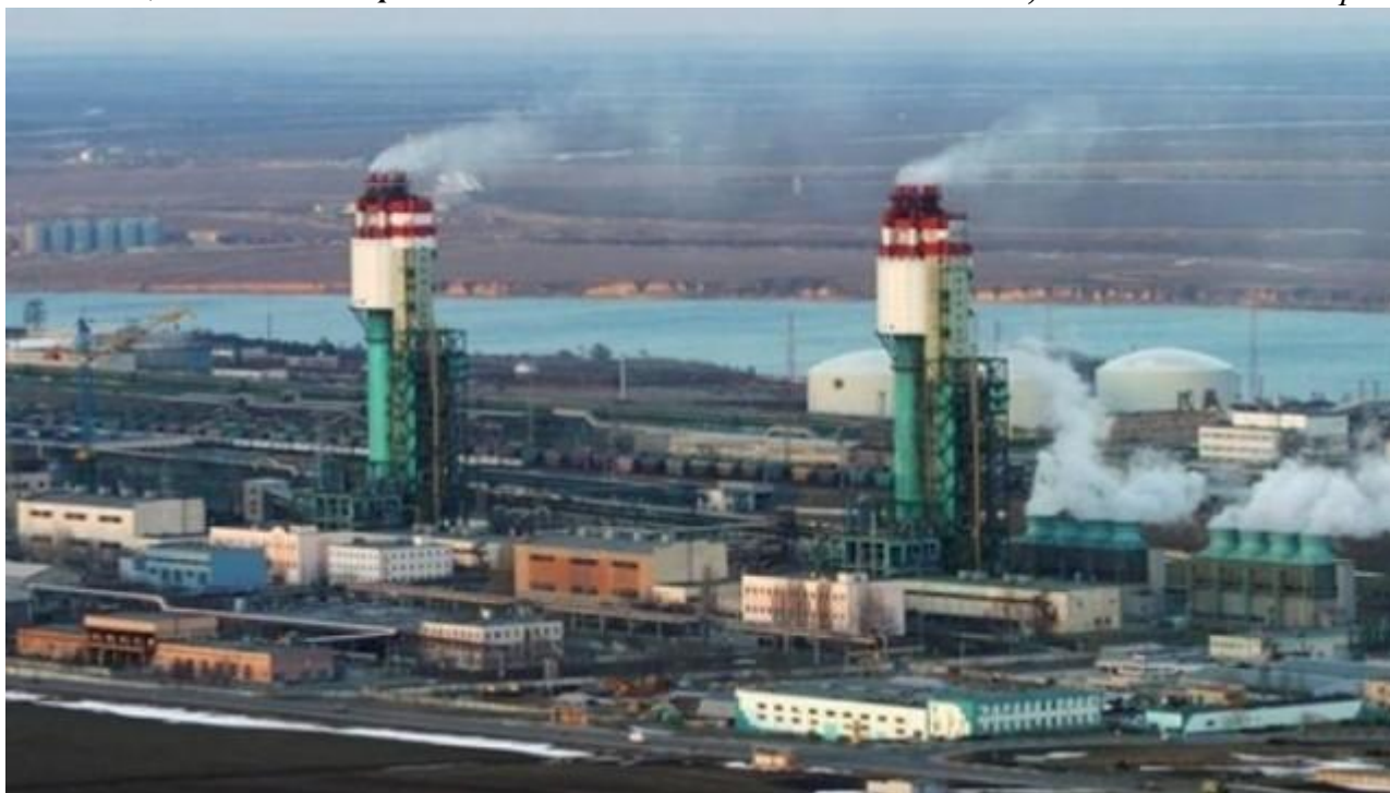
Рис2 представлено цех з виробництва карбаміду Одеського припортового заводу (місто Южне, вул. Заводська, 3).
