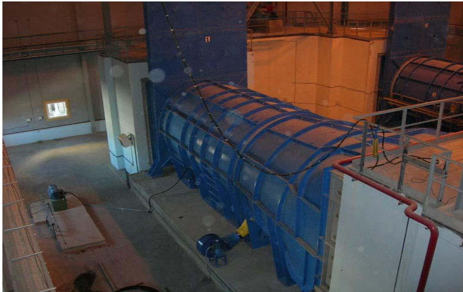
рис. 2. Вентиляційна система шахти
